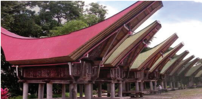
Gambar 6.2 Rumah adat Toraja yang didominasi bahan kayu dan bambu Sumber: http://rumahbagus.info/
