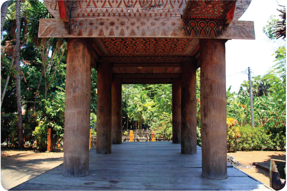
➤ Gambar 3.3. Kolom pada alang berbentuk bulat dan terbuat dari kayu bangah. Sumber: Dokumentasi Weni Rahayu
