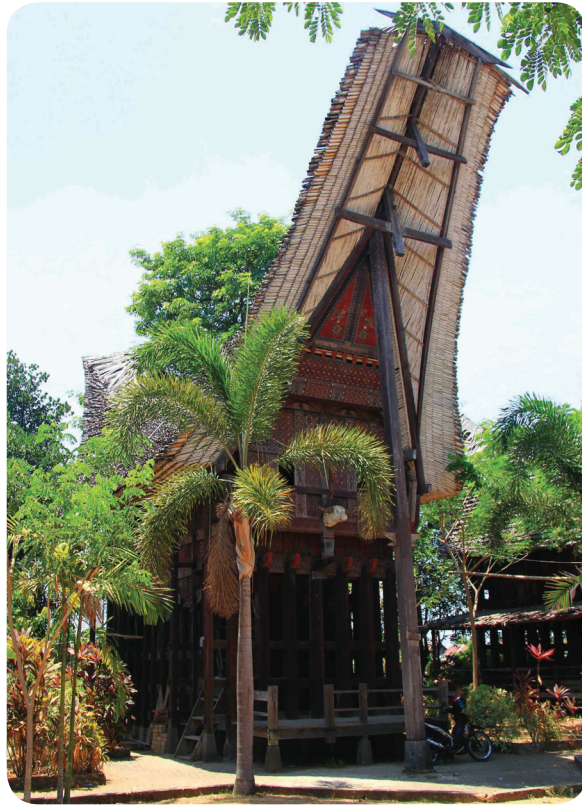
➤ Gambar 2.11. Tongkonan Pekamberan yang dihuni para bangsawan.
