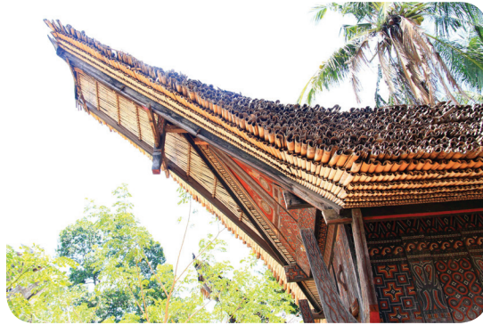
➤ Gambar 3.7. Atap tongkonan dibuat dari bambu yang disusun tumpang tindih..
