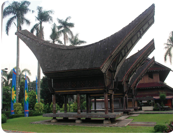
➤ Gambar 2.8. Alang sura yang merupakan pasangan banua tongkonan. Sumber: Dokumentasi Weni Rahayu
