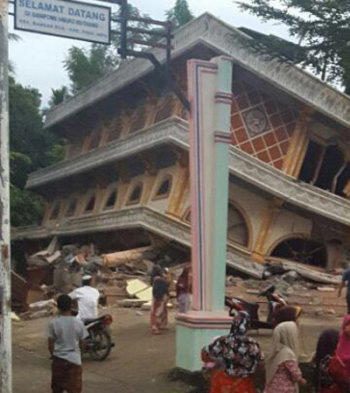
Gambar 5. Kerusakan Akibat Gempa Bumi
