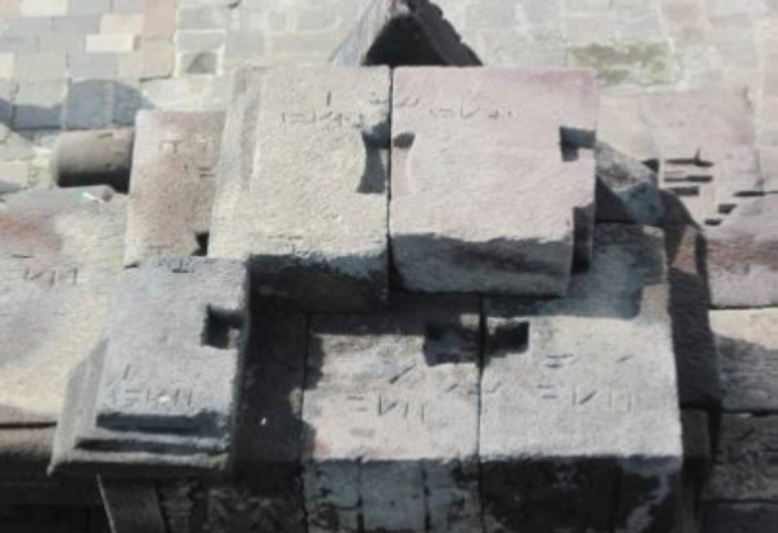
Gambar 16. Pengait Batu Candi yang Saling Mengunci Sumber: konservasiborobudur.org
